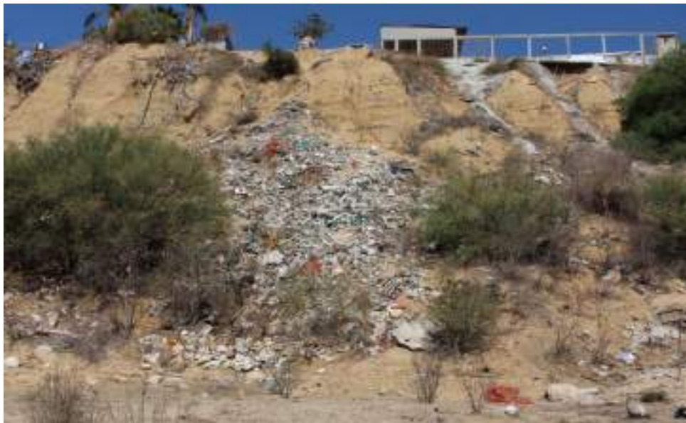
Figura 6. Basurero y construcción sobre un escarpe constituido por depósitos aluviales en las proximidades del Aeropuerto de San José del Cabo
