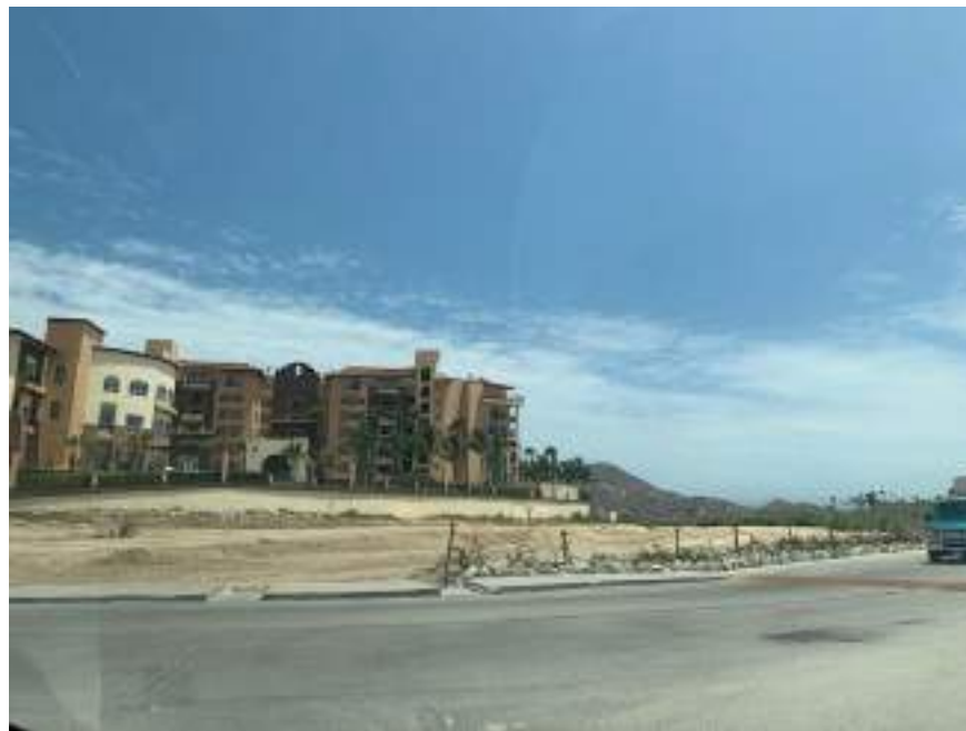
Ilustración 95. Fotografía que muestra una vía de comunicación sobre un lecho seco, en la zona de Camino Real, Cabo San Lucas.
