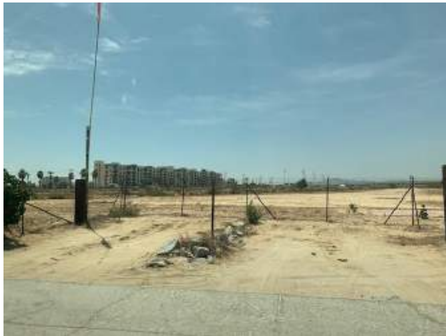
Figura 27. Cerca y camino pavimentado sobre cauce y construcciones a las márgenes.
