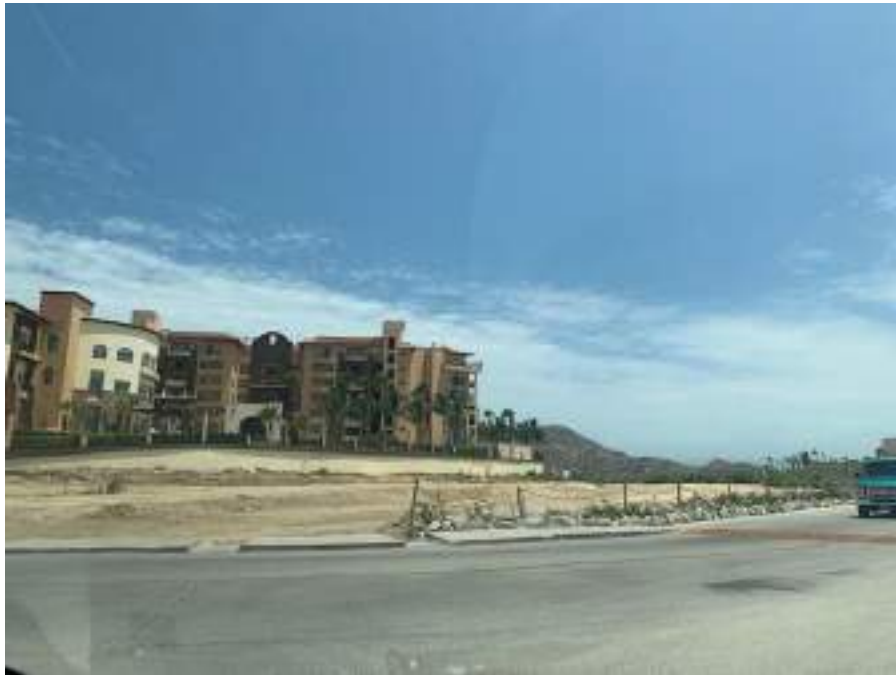
Figura 26. Construcciones en márgenes de cauce y camino pavimentado.
