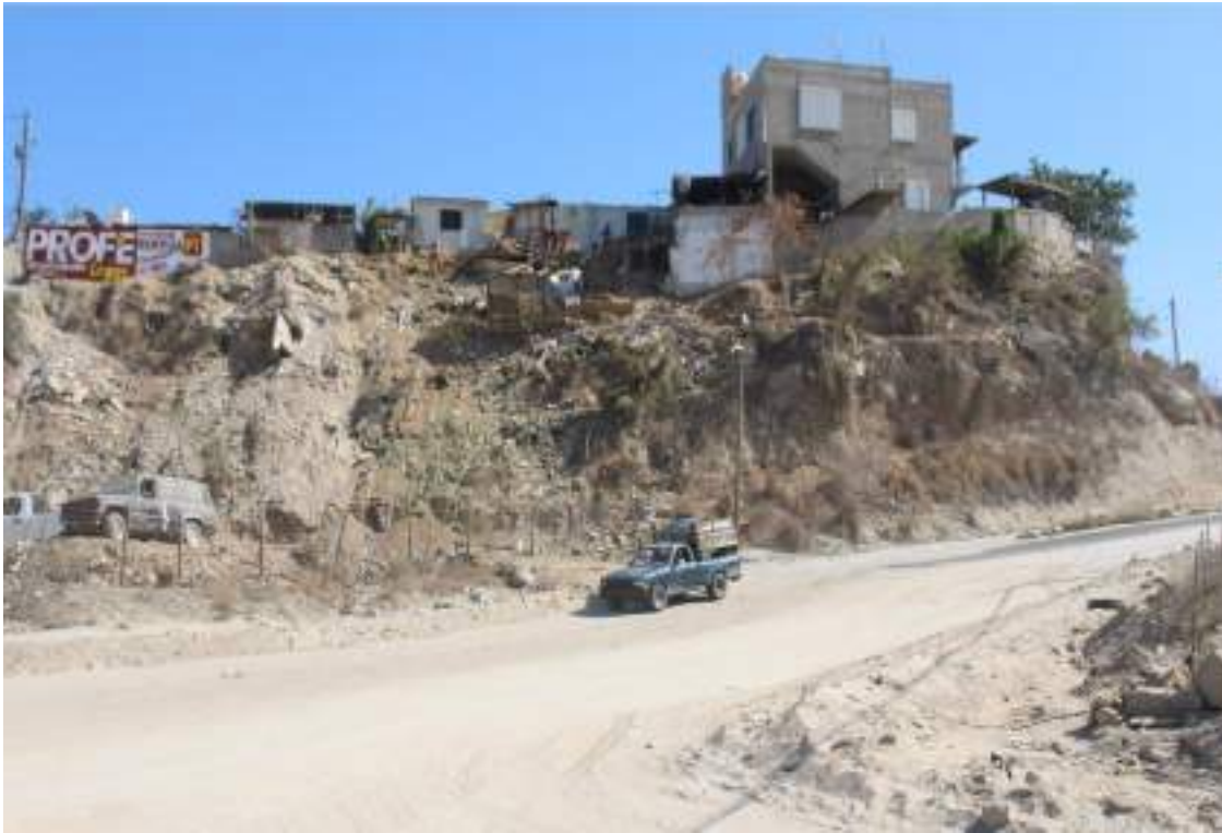
Figura 5. Construcción emplazada en un frente de terraza aluvial
