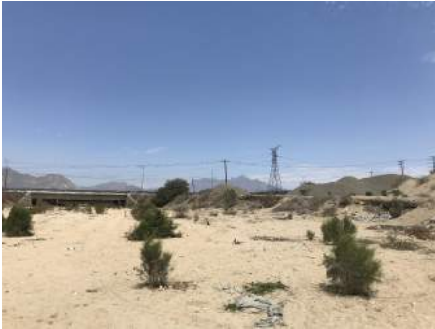
Figura 29. Infraestructura eléctrica sobre cauce seco.
