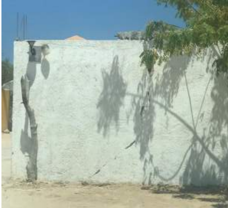
Figura 12. Pared agrietada posiblemente por un movimiento diferencial del terreno en Cabo Pulmo.
