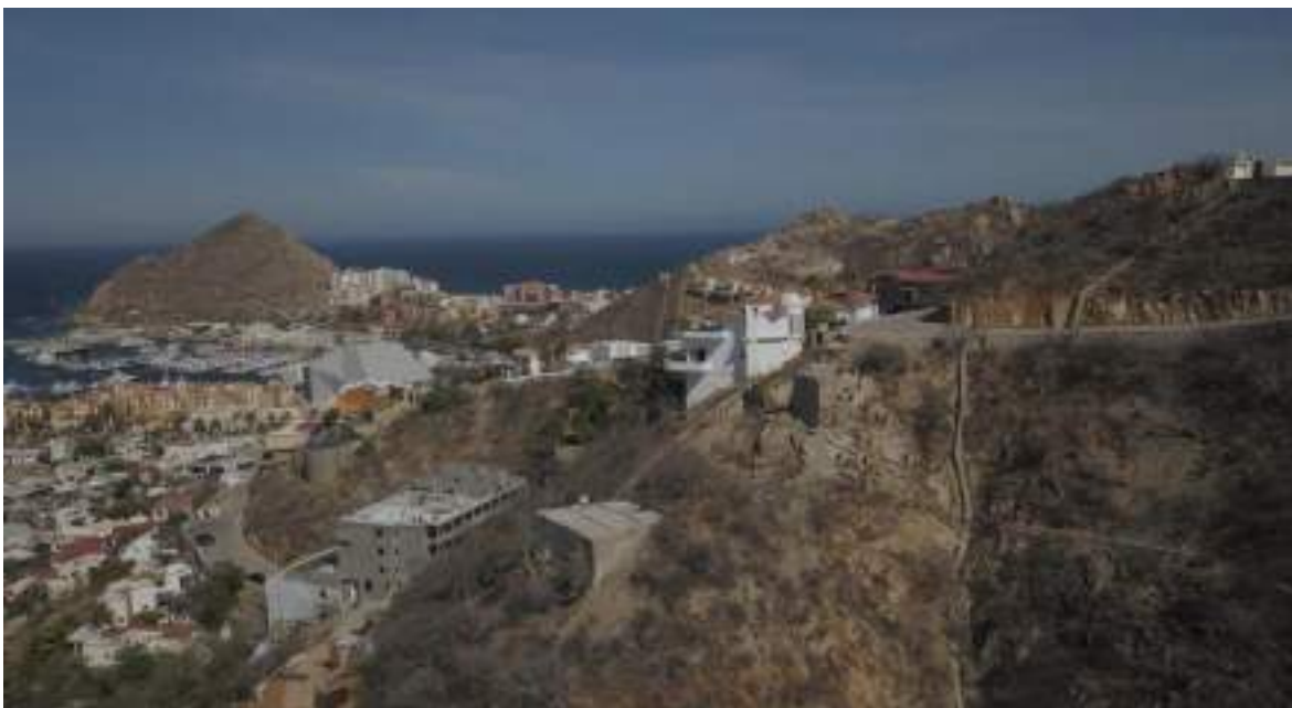
Figura 8. Construcciones en el Pedregal de Cabo San Lucas, Se encuentran en un terreno susceptible a caídas de rocas y deslizamientos.
